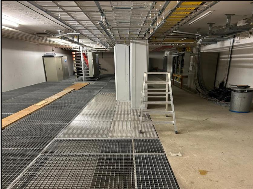
Gitterrostboden bestehend aus Stahl-
